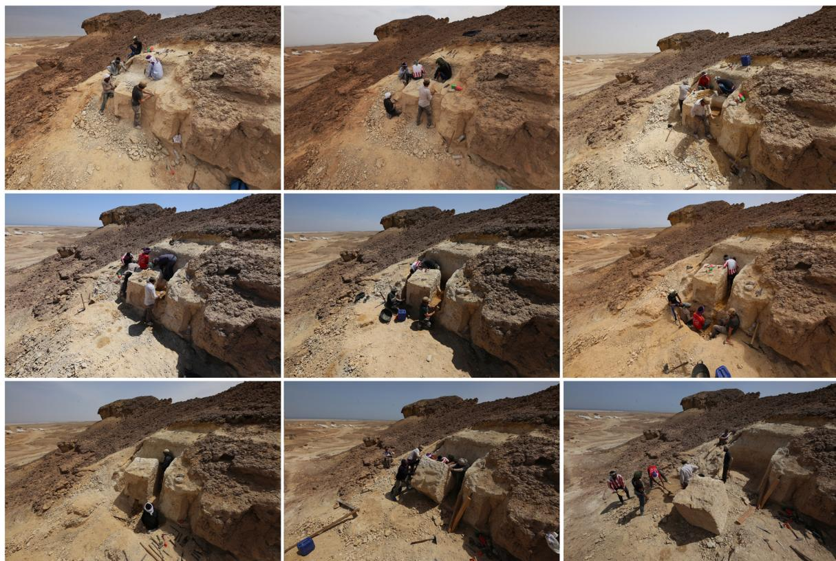
**Fig. 16.** Synopsis de la première campagne d'expérimentation montrant le principe de progression de l'extraction.
